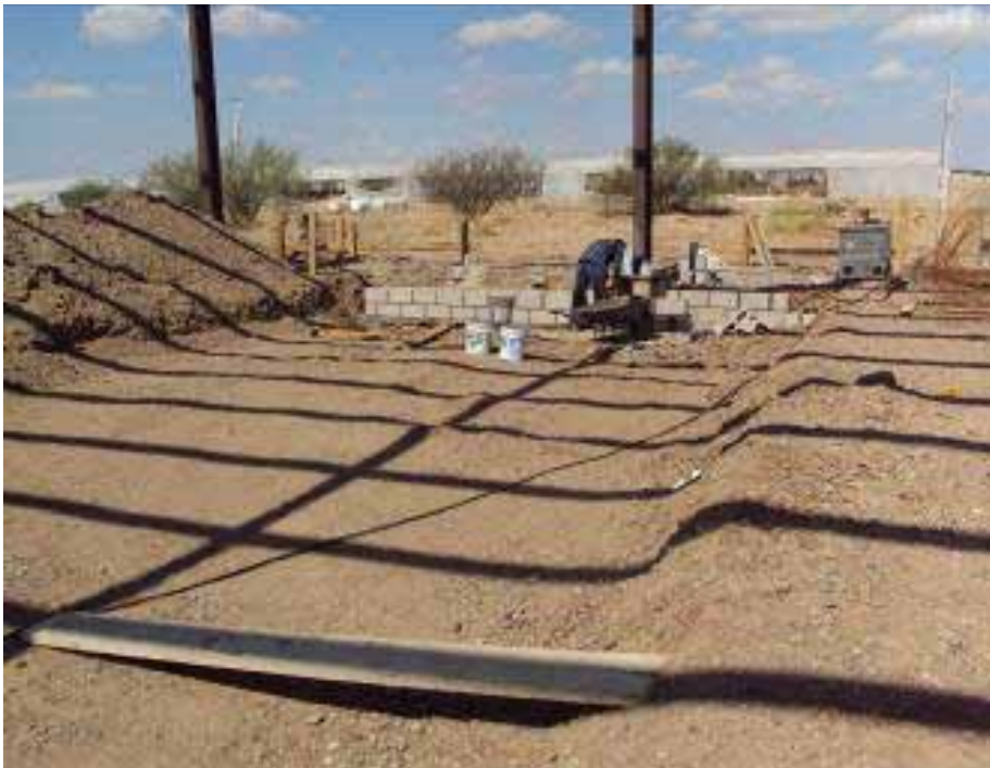
Figura 14. Excavación lista para recibir sistema. Al fondo, construcción de la trinchera poniente (fuente: G. Romero).
