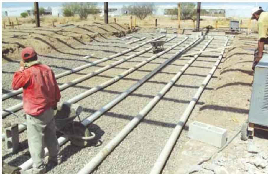
Figura 15. Tendido de cama de grava y colocación de tubos de ventilación perforados (fuente: G. Romero).
