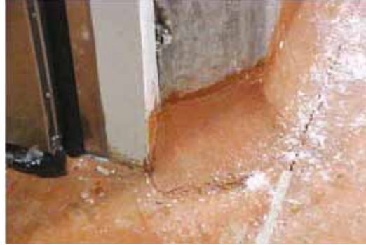
Figura 10. Detalle de firme con problemas de congelación del terreno (fuente: G. Romero).
