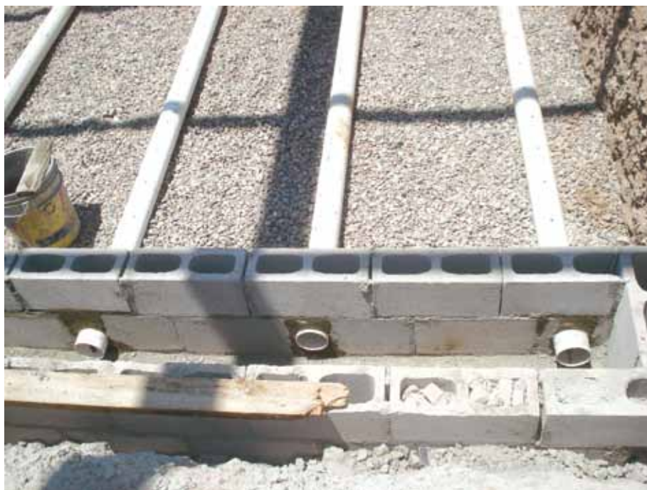
Figura 16. Remate de la tubería en la trinchera poniente (fuente: G. Romero).
